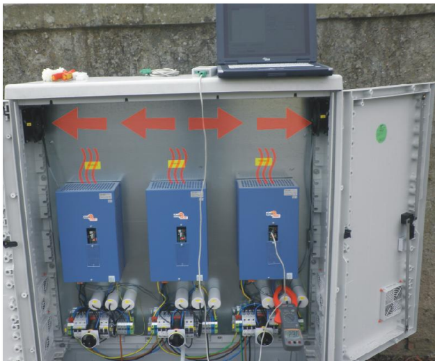
1-1 Entwärmung dreier ZDM-N durch die Schaltschrankwand
